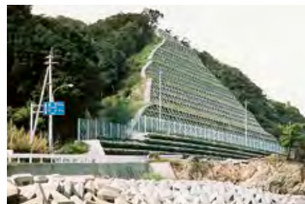
大須防災工事
