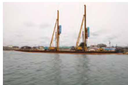
長原堤防耐震対策工事
