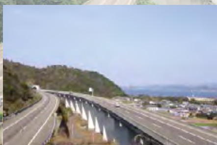
土佐泊浦高架橋
