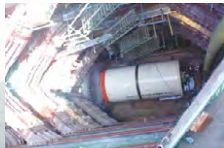
旧吉野川幹線建設工事
