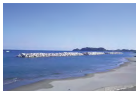
鳴門土佐泊浦海岸災害復旧工事
