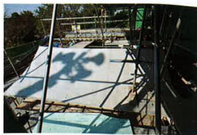
日本瓦を撤去した状態。この上に防水シートを張り、新しい屋根材を取り付ける。
