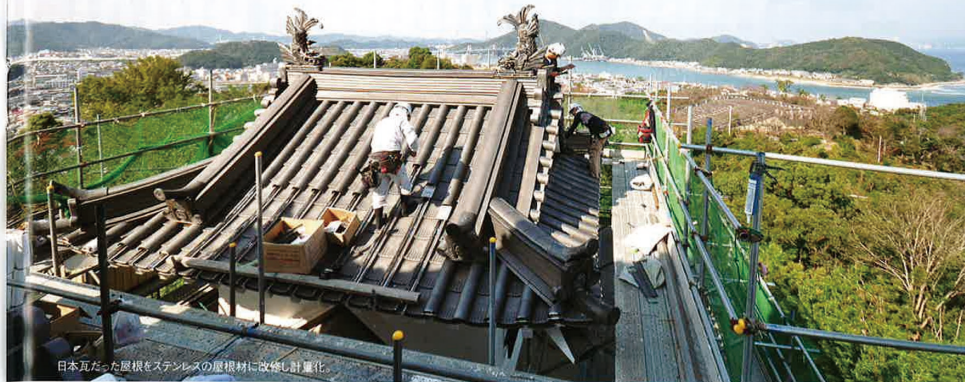
日本瓦だった屋根をステンレスの屋根材に改修し計量化。
