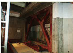
赤い部材が鉄骨耐震プレース。パーツを組み立てながら取り付けている。
