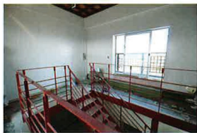
4階部分。従来は四方の壁にあったが強度を高めるため2面をふさいだ。
