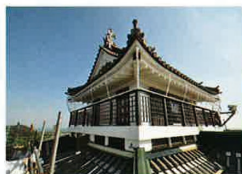
屋根の改修が終了した4階部分。
