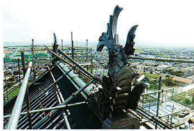
鉤の取付けが完了。鉤は昭和39年に製作されたもので100kgある。
