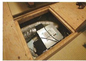
夏は涼しく冬は暖かい床下の地中熱を利用した空気循環させる床下換気ユニットは和室の床下に設置されている。常にモーターが回っているがモーター音はほとんど聞こえない。
