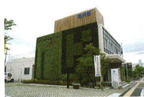
駐車場を緑化スペースに活用。 壁面緑化には亀井組の「K」の文 字が。
