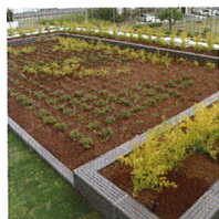
屋上緑化。自動水やり システムを装備してい るから手間いらず。
