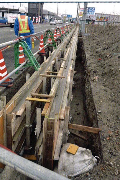
こちらの延長は40メートル。現在、工事全体の3割ほどまで進んでいる。
