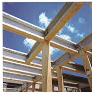
鉄の強さと木のしなやかさを備えた複合梁「テクノビーム」が、万が一地震に見舞われてもしっかりと家族を守ります。
