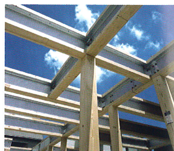
鉄の強さと、木のしなやかさ。それらを併せ持った複合梁「テクノビーム」が、地震に見舞われてもバランスのとれた強度を保ちます。
