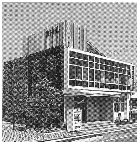
屋上やガラスに太陽光パネルを設置した(徳島県鳴門市の本社)
