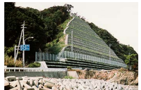
大須防災工事
