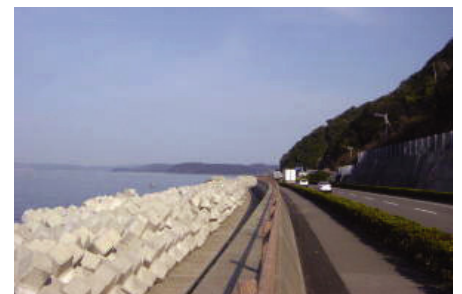
北灘防災工事
