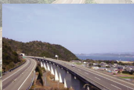
土佐泊浦高架橋
